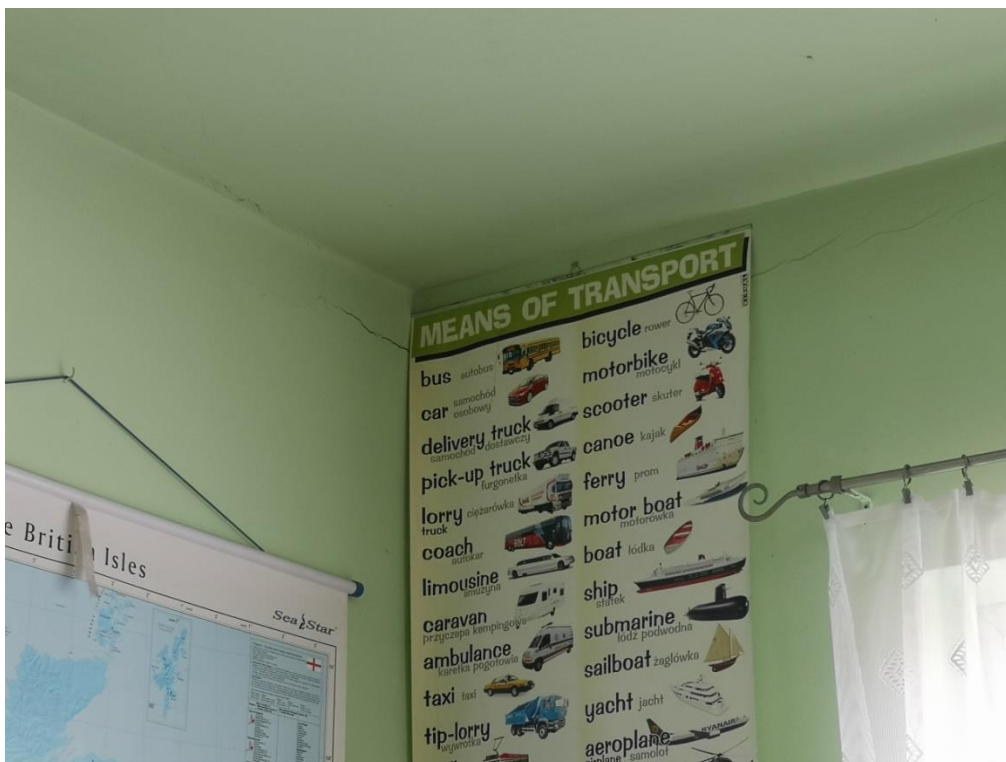
Fot.13 Poziome pęknięcie w narożniku północno-zachodnim w pomieszczeniu W15 spowodowane silnym ugięciem stropu
