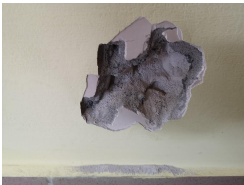
Fot.3 Odkrywka warstw ściany działowej na I piętrze
