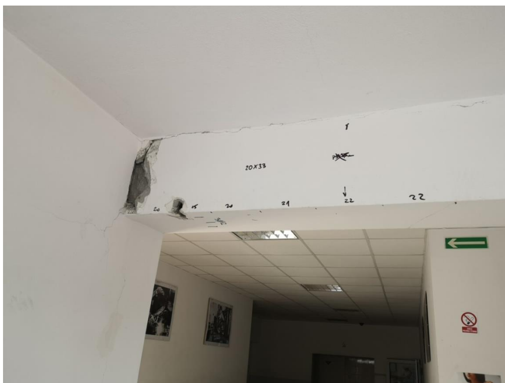
Fot.22 Inwentaryzacja zbrojenia w belce żelbetowej na styku łącznika i części dobudowanej warsztatów
