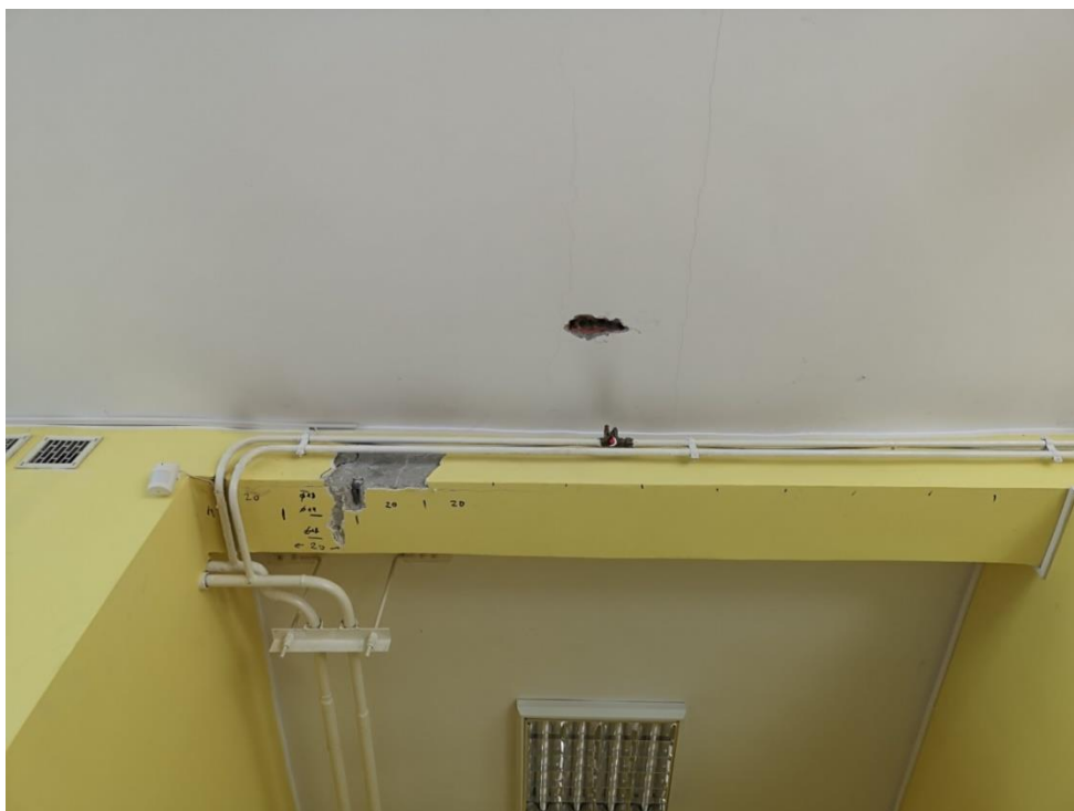
Fot.19 Miejsce wykonania odkrywek zbrojenia belek stropowych oraz podciągu żelbetowego w auli. Widoczne usytuowanie strzemion
