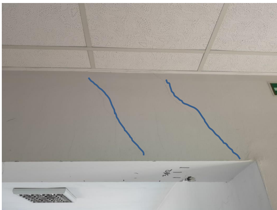
Fot.24 Rysy ukośne w belce jw.
